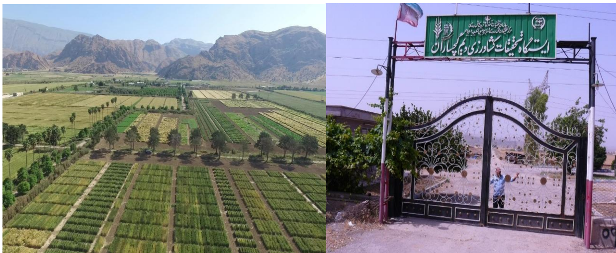
شکل ۱-۳- نمای ساختمان ایستگاه تحقیقات کشاورزی دیم گچساران
